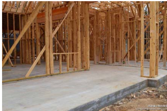
Ảnh 2: Phần móng của nhà gỗ tại Mỹ
